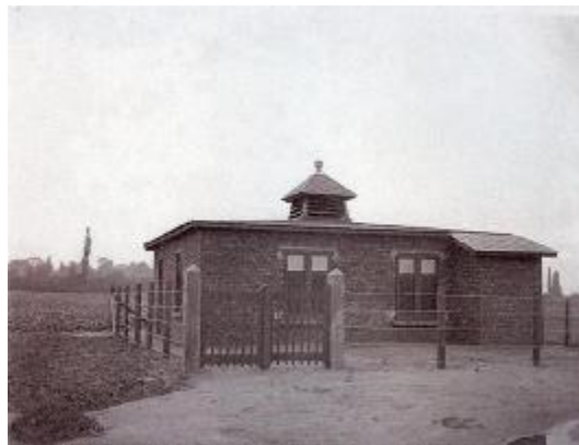
Dit blok van beton en baksteen is de bunker B29 in Bottelare (foto: www.bunkergordel.be ). De foto rechts toont hoe hij er ooit uit zag. Het kapelletje op het dak hield de metalen "bespiedingsklok" verborgen. (foto: Collectie De Muntenaar)
