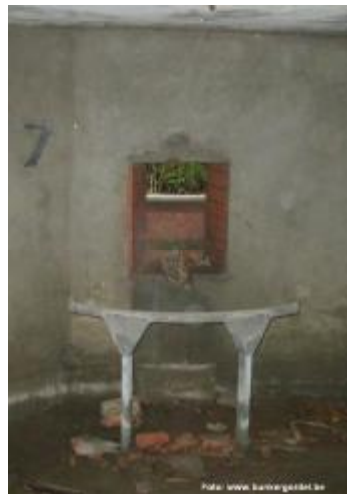
Vrij intacte opstelling voor de Maxim – mitrailleur, uit de verdwenen B46 bunker te Melle (foto: www.bunkergordel.be )
