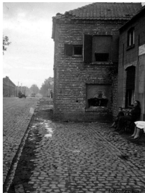
Deze 2 zware bunkers met bovenverdieping stonden te Semmerzake en te Kwatrecht en waren op het gelijkvloerse deel uitgerust met een een vast opgesteld 47 millimeter kanon. Bovenaan bevond zich een schietgat voor een mitrailleur en schijnwerper die op de weg gericht konden worden Ze waren totaal niet te onderscheiden van de gewone bebouwing.
