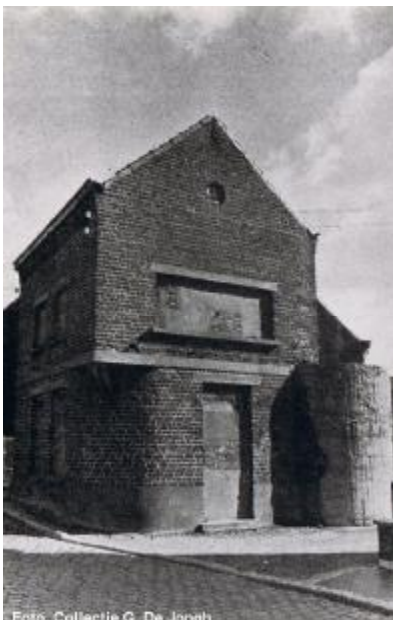
Deze 2 zware bunkers met bovenverdieping stonden te Semmerzake en te Kwatrecht en waren op het gelijkvloerse deel uitgerust met een een vast opgesteld 47 millimeter kanon. Bovenaan bevond zich een schietgat voor een mitrailleur en schijnwerper die op de weg gericht konden worden Ze waren totaal niet te onderscheiden van de gewone bebouwing.
