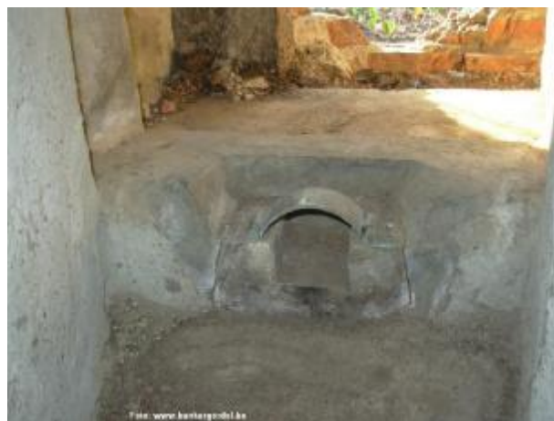
De geheel intacte binnenzijde van een bunker die op deze wijze werd uitgerust. Zowel de klem in het schietgat als het "chardome" als de bakjes met de eikenhouten blokjes zijn duidelijk zichtbaar. (foto's: www.bunkergordel.be )
