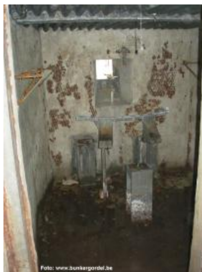
Intacte binnenkant van een bunker voor de opstelling van een Hotchkiss- of Coltmitrailleur. Dit is de bunker D22, ingebouwd in het spoorwegviaduct te Kwatrecht. (foto: www.bunkergordel.be )
